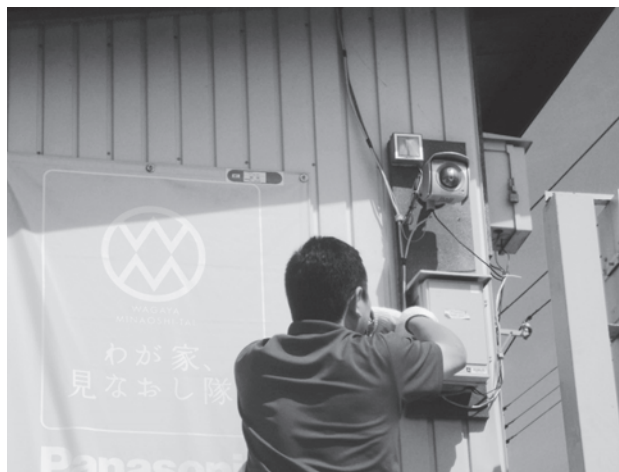
施工済ネットワークカメラの点検作業
