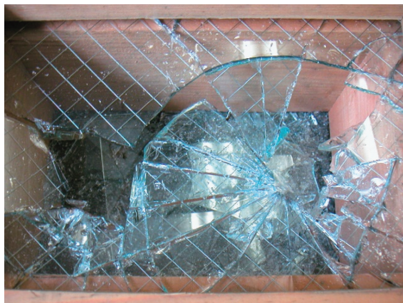
網入りガラスは強いと誤解している方が多いが、簡単に破ることができる。ガラスが割れ落ちず大きな音もしないため泥棒の好むガラスでもある。
