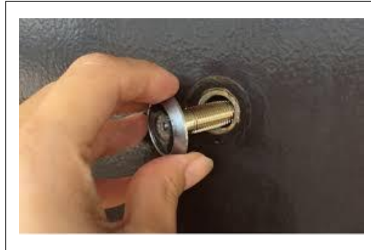
写真 2.8 ドアスコープの取外し例
