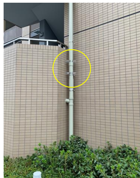
写真 5.4 バルコニー樋に忍び返しを設置した例
