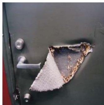
写真 2.3 戸板破りの例
