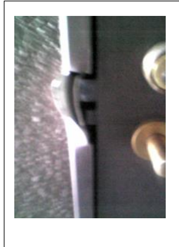
写真 2.1 ドア錠こじ破り例
