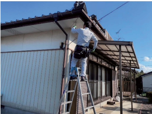
センサーライトを依頼され取付してる様子
