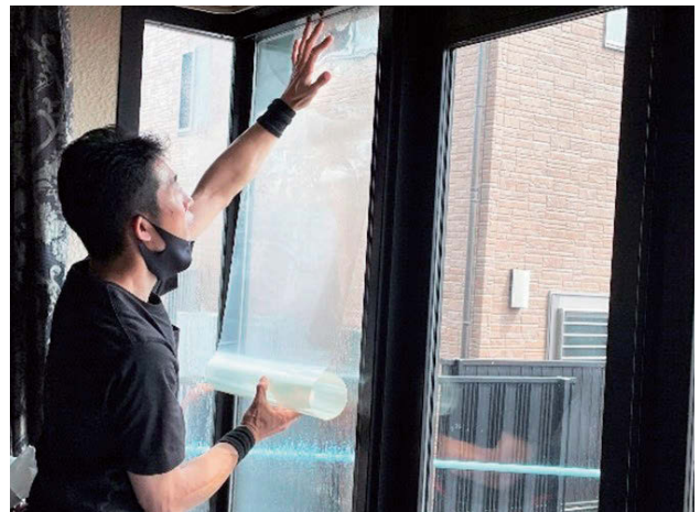
防犯フィルムの依頼があり施工している様子
