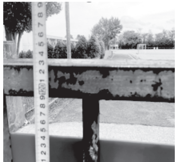
正門の高さを測っているところ
